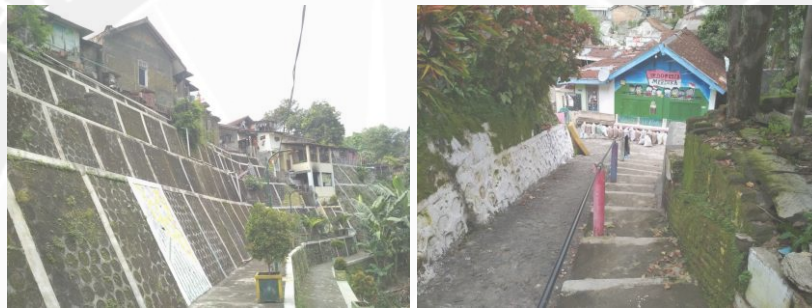
Gambar 109. Talud pada RW 10 (kiri) dan Persimpangan Jalan pada RW 11 (kanan) Sumber : Analisis Penulis, 2018
