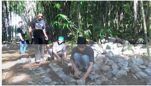
Gambar 89. Pemasangan Jalan Trasah
