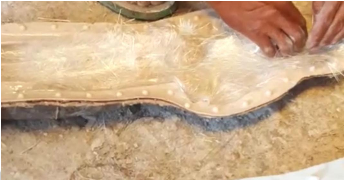
Pekerja Melapisi Fiber pada saat Pengecoran
