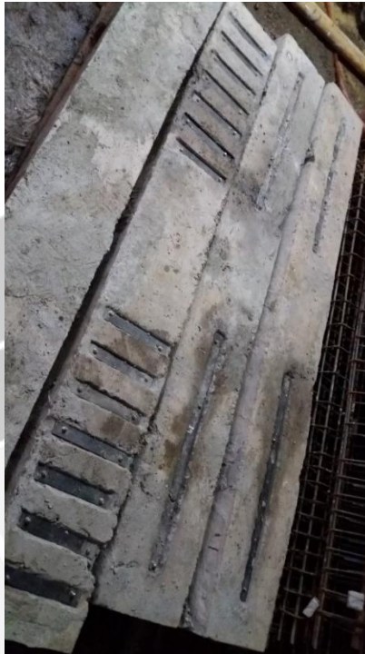
Gambar 5. Pemasangan Baja Strip
