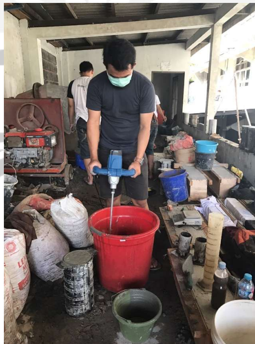
Pengadukan Campuran Beton Foam
