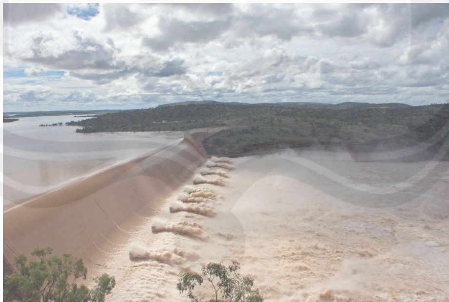
Gambar 1.1. Lompatan hidrolik pada Bendungan Burdekin, Australia.
