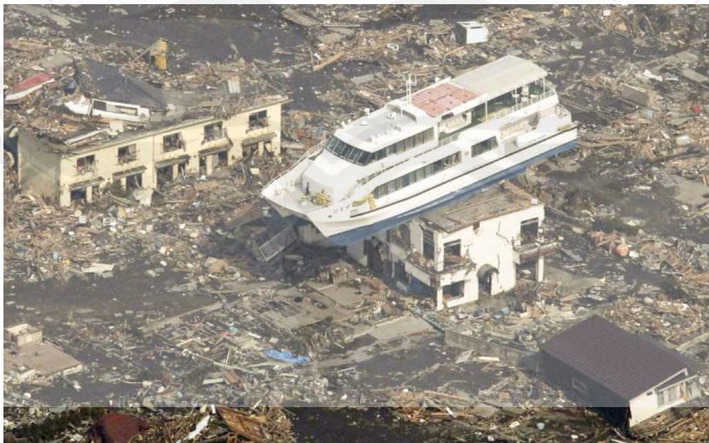
Gambar 1.2. Tsunami menghempaskan sebuah kapal hingga berada di atas sebuah bangunan di tengah puing-puing di Otsuchi, Prefektur Iwate, Jepang, 14 Maret.
