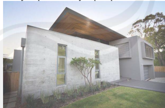
Gambar 3.3-20 : Material Beton Ekspos.
