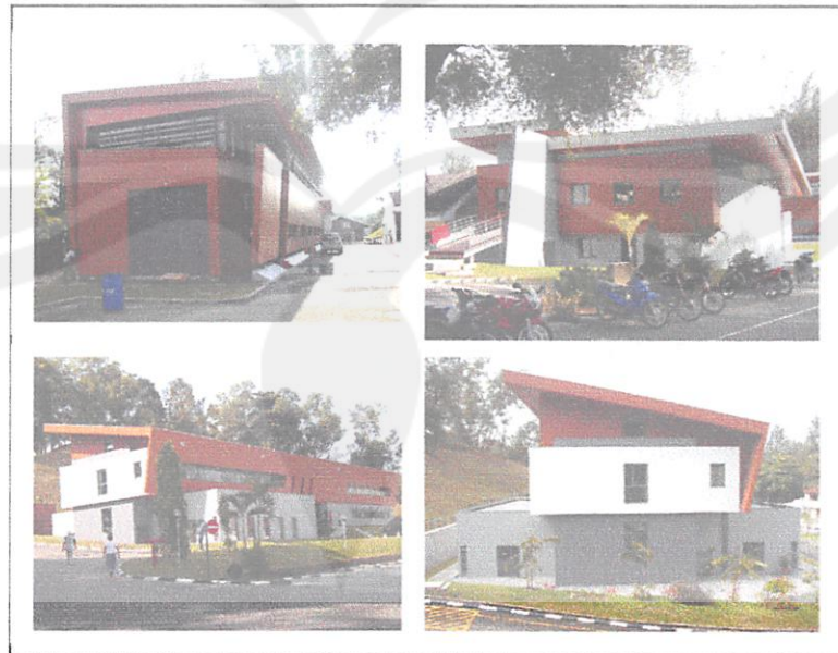
Gambar I.4 Bangunan baru dan renovasi bangunan lama (OFA,OFB,OFL) Total E&P Indonesia
